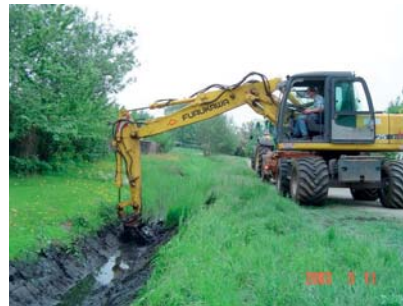
Abb. 16: Maschinelle Grundräumung mit Bagger
