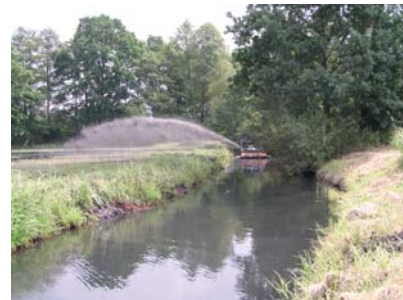
Abb. 17: Schwimmender Saugbagger mit Sprühtechnik
