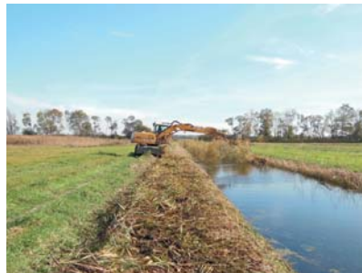
Abb. 12: Maschinelle Krautung mit Mähkorb
