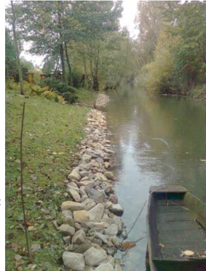
Abb. 28: Steinschüttung zur Ufersicherung
