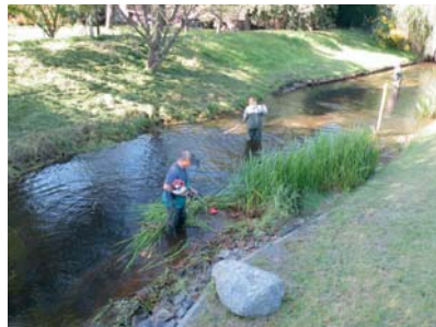
Abb. 10: Handkrautung mit Elektrosense
