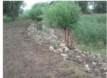
Abb. 48: Steinschüttung als Uferschutz vor wühlenden Tieren
