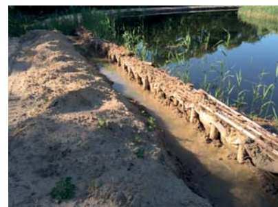
Abb. 29: Faschinen zur Ufersicherung
