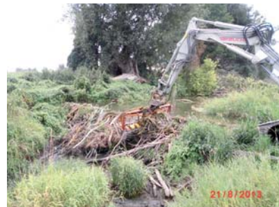
Abb. 41: Entfernen eines Biberdamms
