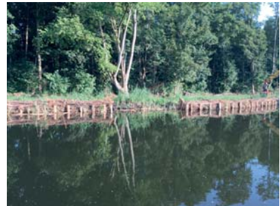
Abb. 35: Ingenieurbioologische Bauweise zur Uferbefestigungen
